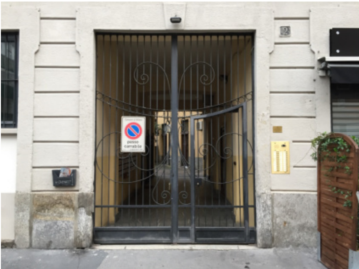
Foto 06 - Accesso al fabbricato di via Guido Cavalcanti al civico 2
