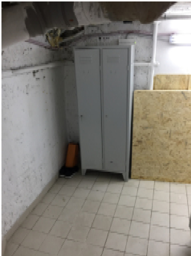
Foto 24 - Deposito al piano interrato
