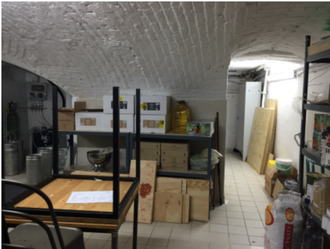
Foto 25 - Deposito al piano interrato
