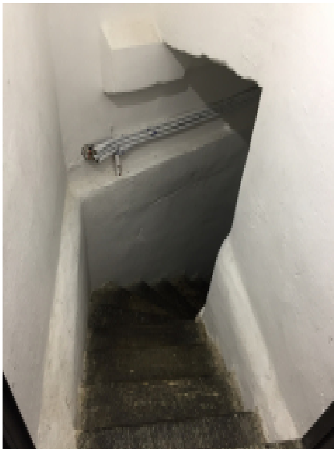
Foto 23 - Scala accesso al piano interrato
