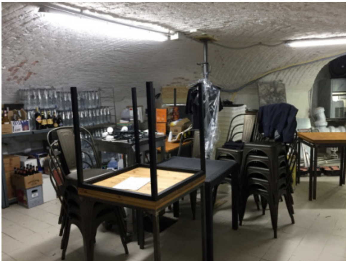
Foto 29 - Deposito al piano interrato
