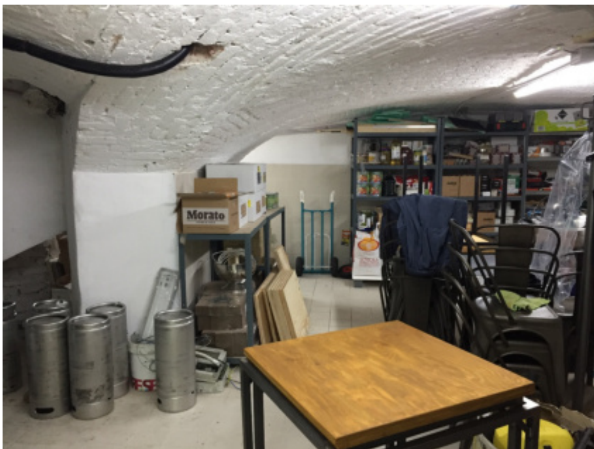
Foto 26 - Deposito al piano interrato
